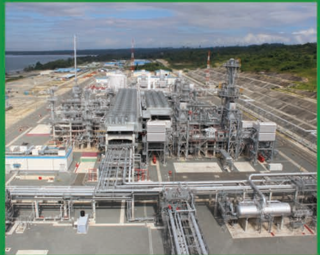
Sumbawa LNG Terminal & Regas Facility Project
